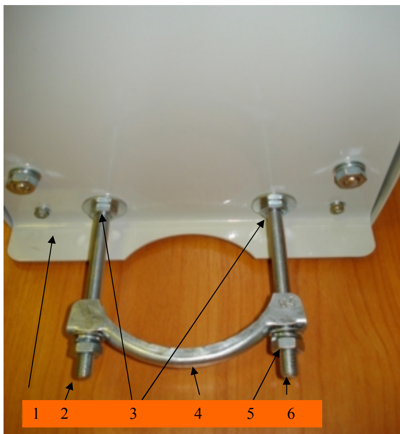
Рис. 2 Узел крепления БПЭС.
